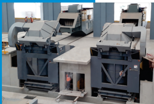
Carregamento de Forno com Exaustão
