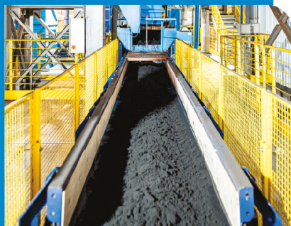
Transporte de areia preparada
